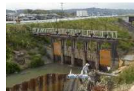
城内井堰（河合町）
