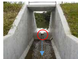
余水吐の切り欠きによる 治水容量確保 （上新池・葛城市）
