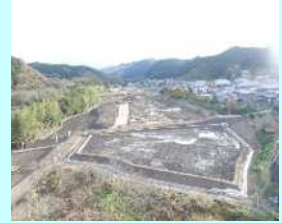
施工中の状況 (丹原地区・五條市)
