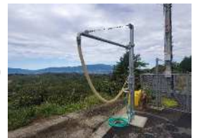
給水スタンドの設置 （湯塩地区・五條市）
