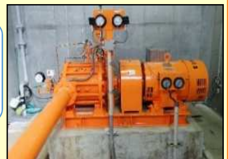
8号揚水機場(R3完成)
