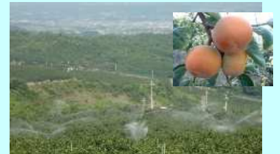
自動かん水制御システム導入試験 (五條吉野地区)
