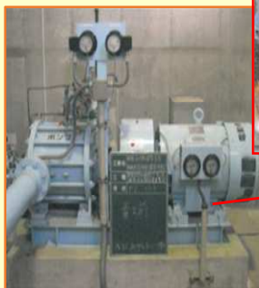
8号揚水機場(H11造成)
