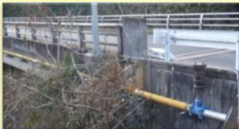
清水大橋水管橋
