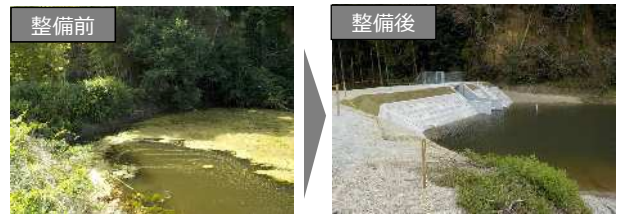
ため池改修（葛城山麓地区・葛城市）
