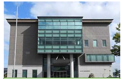
現在の事務所 (大和平野土地改良区4階)
