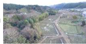
ほ場整備による区画拡大 （丹原地区・五條市）
