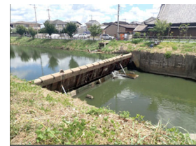
尼ヶ辻井堰 (奈良市)
