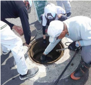
施設点検のようす
