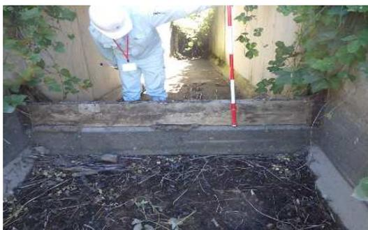
洪水吐への堰板及び土のうによる嵩上げ
