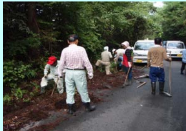
側溝の泥上げ
